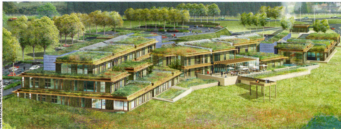
L'équipement, édifié sur trois niveaux, aura nécessité 700 m 3 de bois et 5830 m 2 de plancher.
